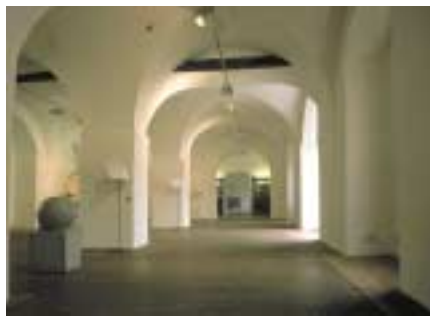
Einblick in das nicht unterkellerte, mit Bodentemperierung ausgestattete Lapidarium der Kartause Mauerbach bei Wien
